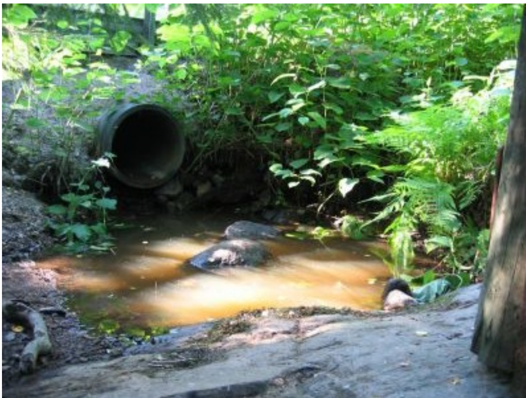
Kuva 2: Vähä-Henttaan tien siltarummun alapuoliseen lammikkoon oli pakkautunut valtaosa viimeisistä sinnittelevistä taimenista.
